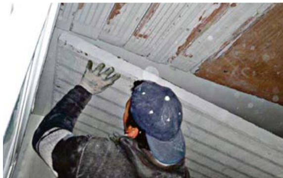
■ So wurden die Dämm- und Kapillarrohmatte in den Decken des Hauses installiert. FOTO: CASA FELIZ
